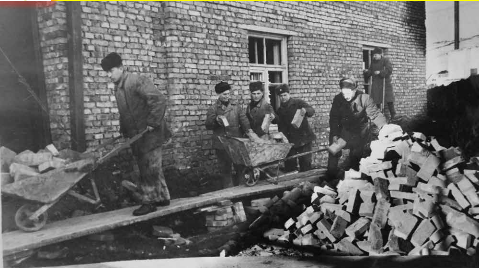
Строительство ВПЧ-3 г. Мурманска. Фото: начала 70-х
