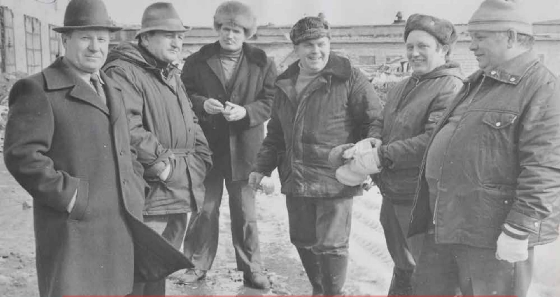
1978 год. На строительстве отряда технической службы. Какушкин И.Н., Гедерим А.П., Чабанов А.А., Гришин Н.И., Бурцев В.И., Крылов А.С.
